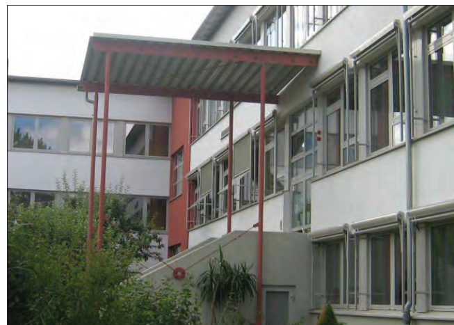
AfG-Fortbildungscampus im Schulzentrum Gräfenberg
