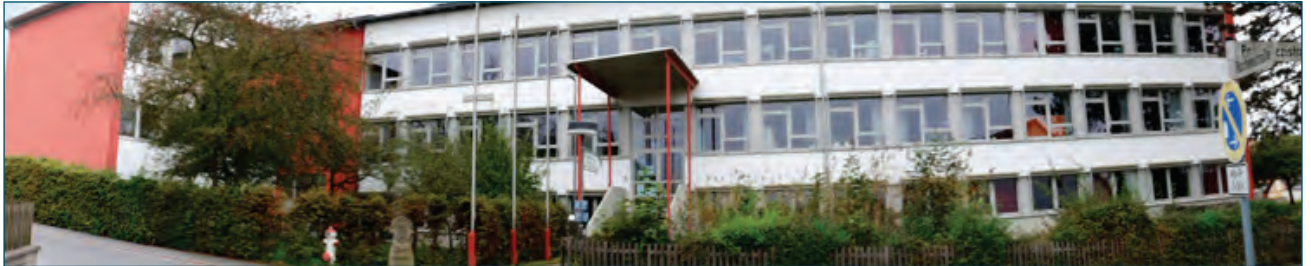
AfG-Fortbildungscampus im Schulzentrum Gräfenberg
