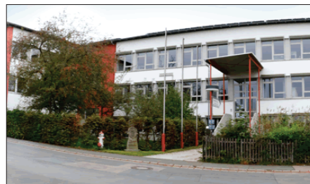
AfG-Fortbildungscampus im Schulzentrum Gräfenberg
